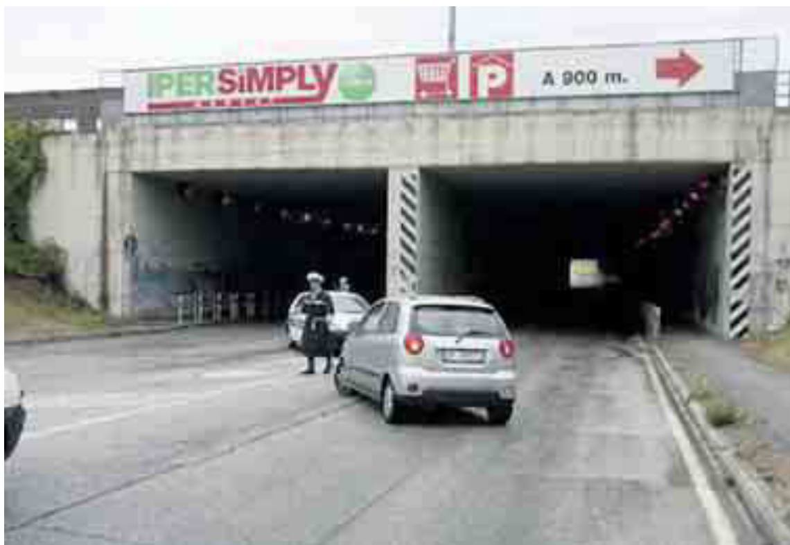
Una deviazione davanti al sottopasso del Multisala a causa dei problemi strutturali
